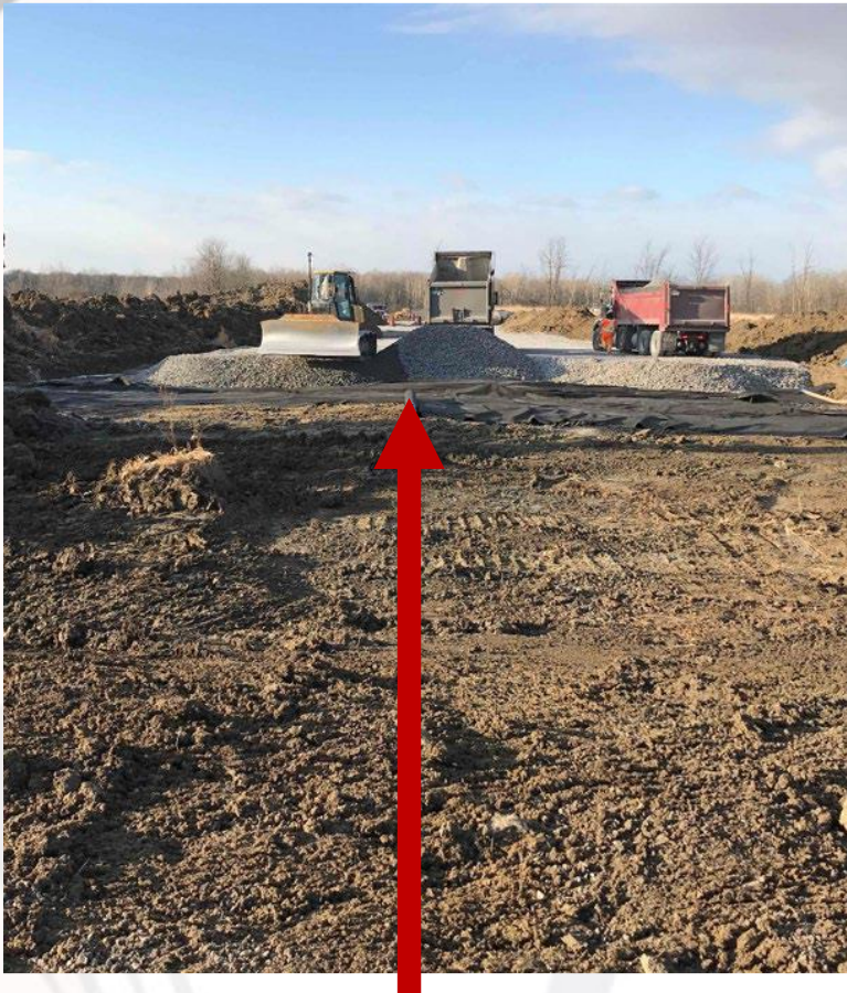
Enlèvement de la première couche et obturation entre les chemins Bowesville et Limebank
